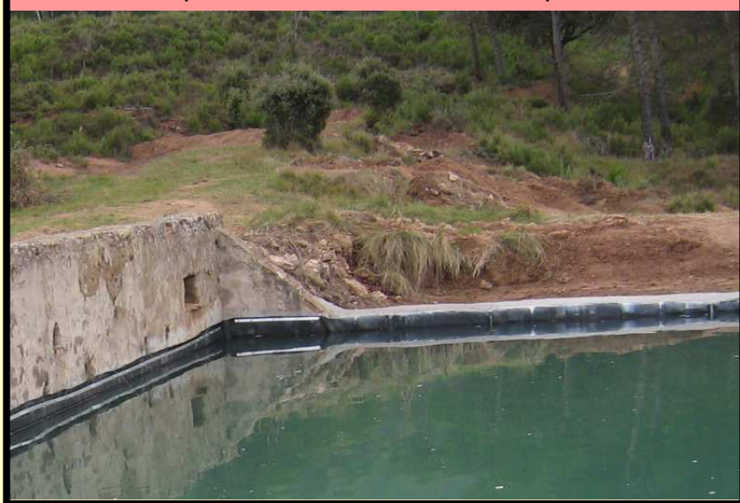
Bassa impermeabilitzada amb lona impermeable
